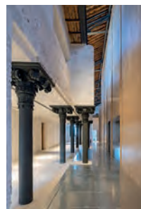
修復された鉄柱の柱
