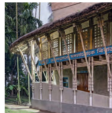
竹材による支柱の構成を見る
