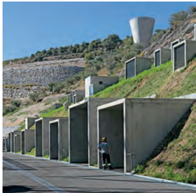
上部に測定塔、下部に通気口/アクセス用ボックスを見る
