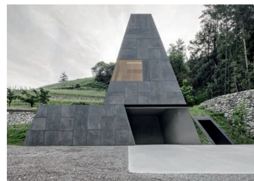
ピラミッド・タワー：下部の壁をスライドさせるとブドウ搬入口となる
