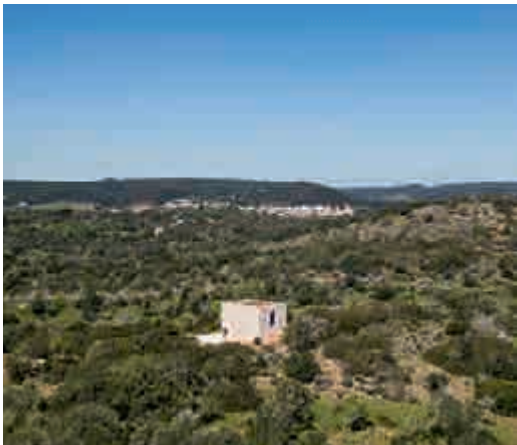
南東からの俯瞰
