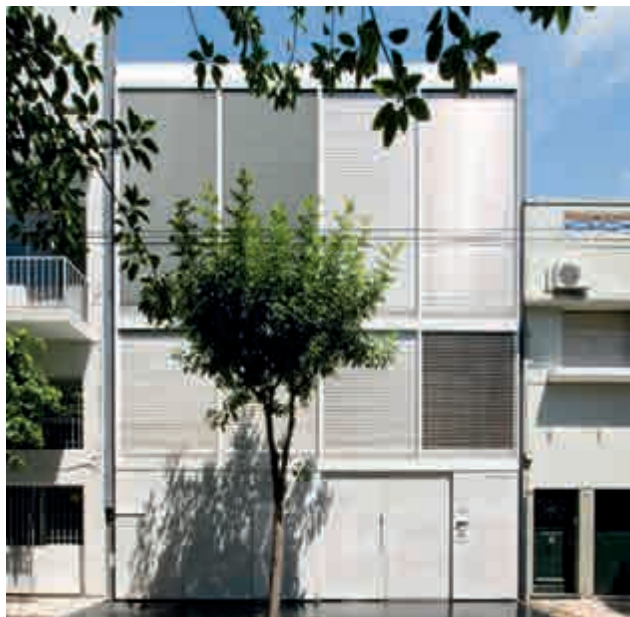
街路側ファサード
