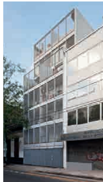
街路側ファサード
