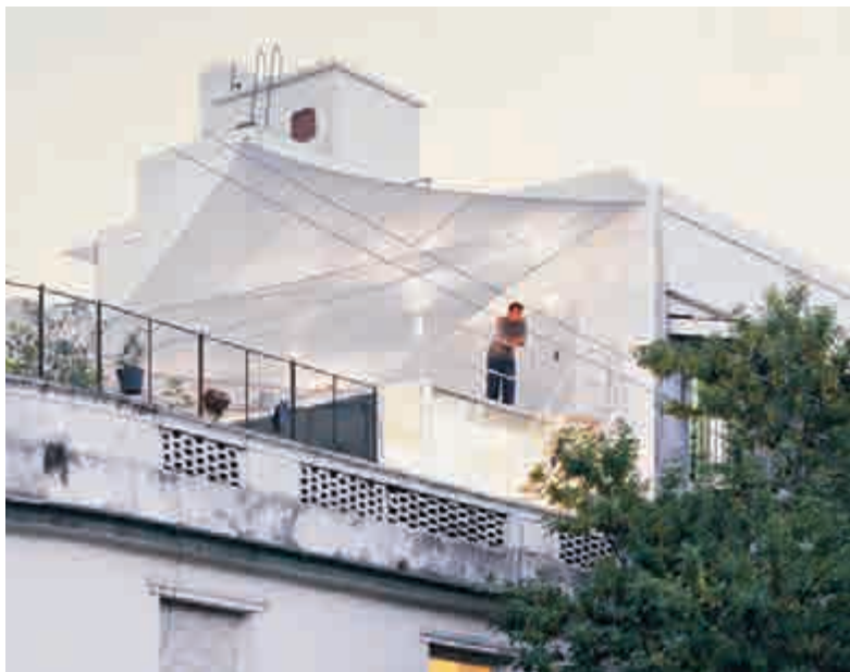
建物上部を見る
