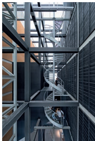
構造体に挿入された螺旋階段
