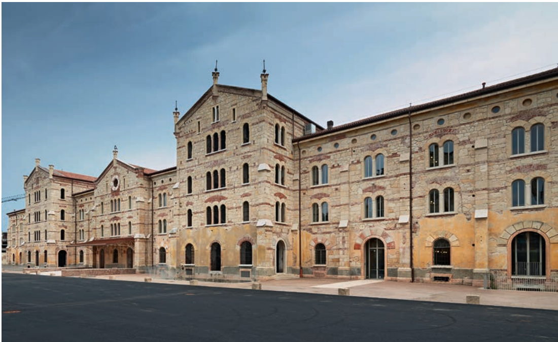
北側ファサード：左にメイン・エントランスを見る
